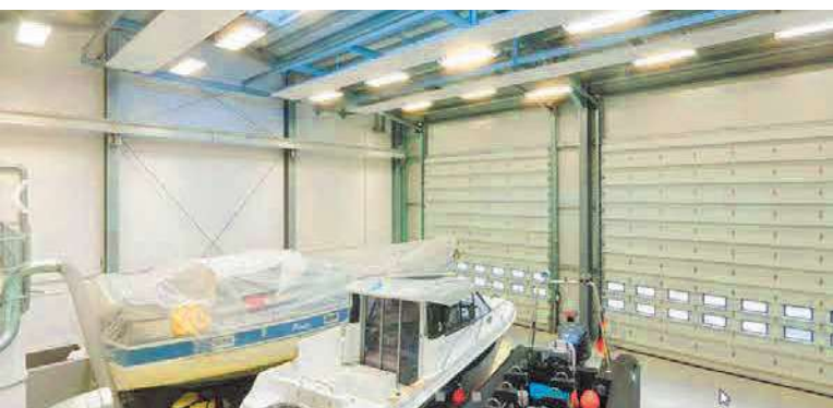
Referenz von HAB Hallen- und Anlagenbau: Die Bootshalle in der Marina Kroeslin.
